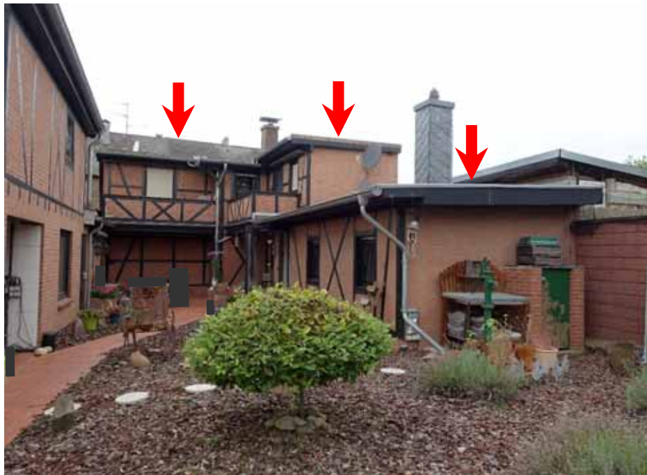
Rückansicht des Vorderhauses mit zwei Anbauten
