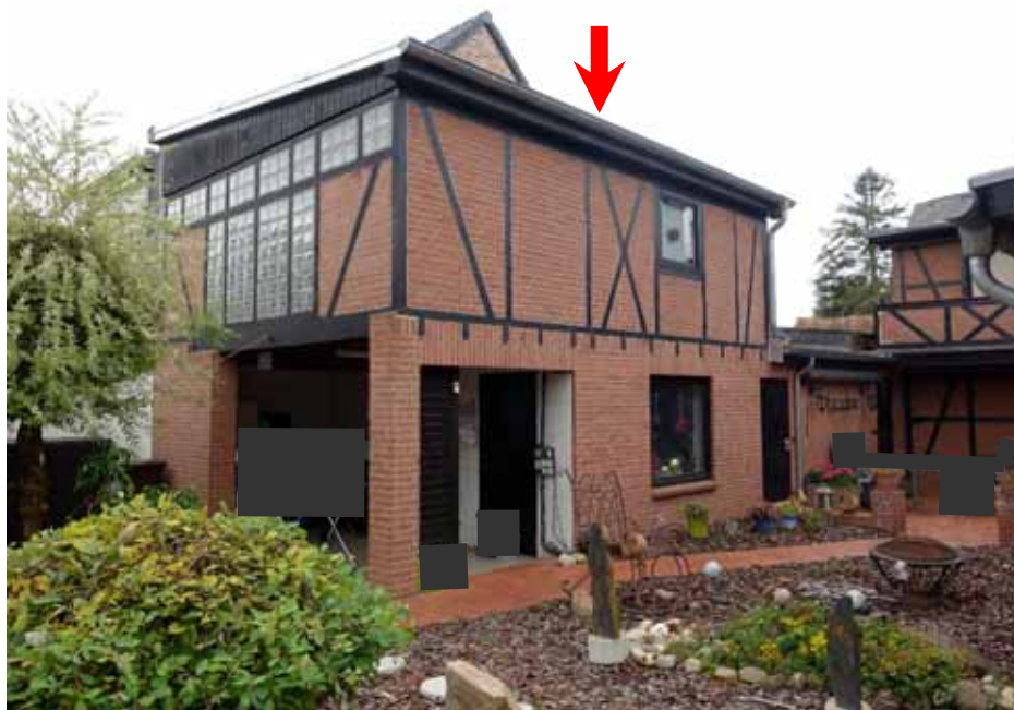
Rück-/Seitenansicht des Garagengebäudes
