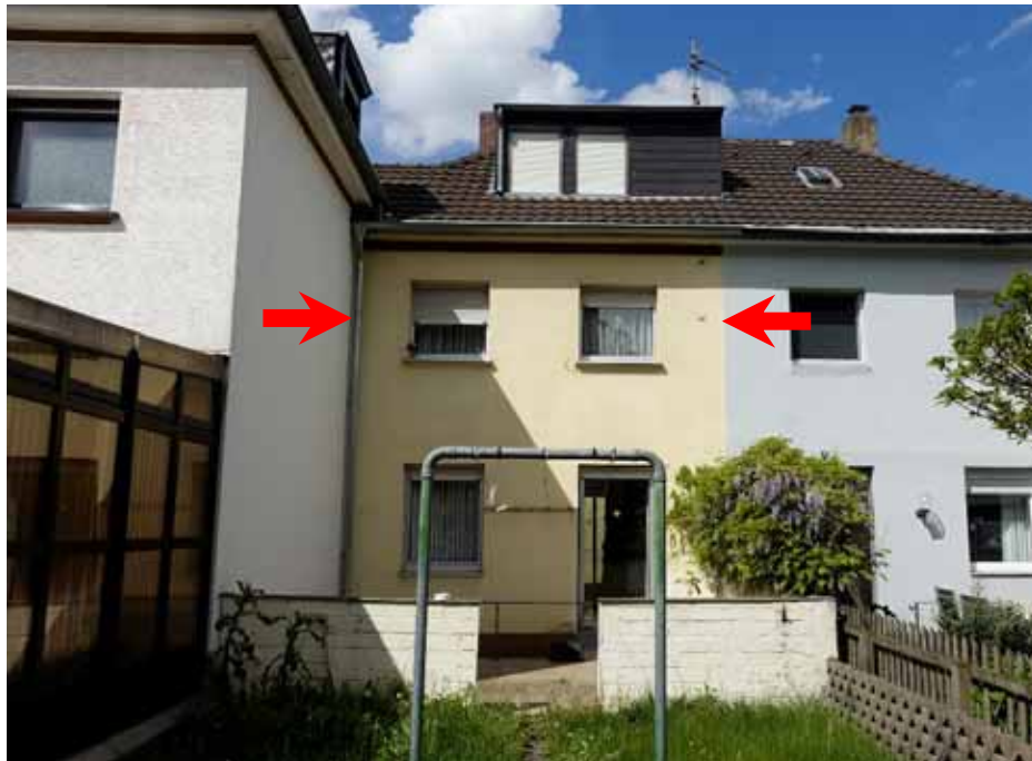
Rückansicht des Wohnhauses
