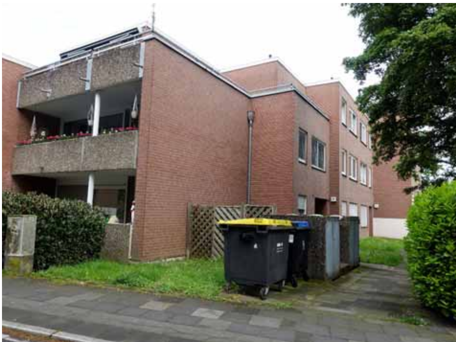
Zuwegung zu den Mehrfamilienhäusern „Hahnenstraße 12, 14“
