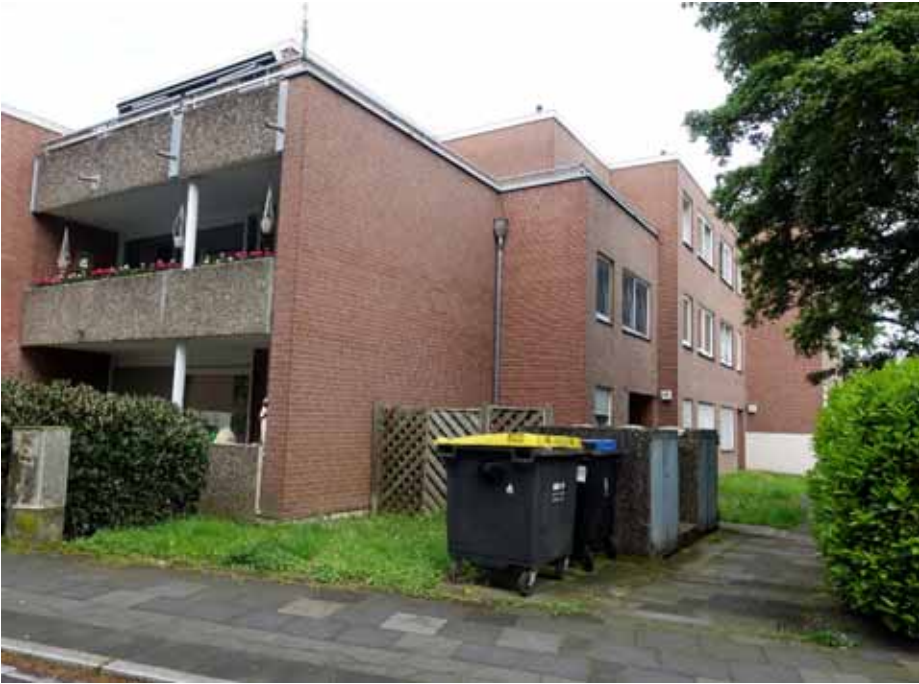
Zuwegung zu den Mehrfamilienhäusern „Hahnenstraße 12, 14“
