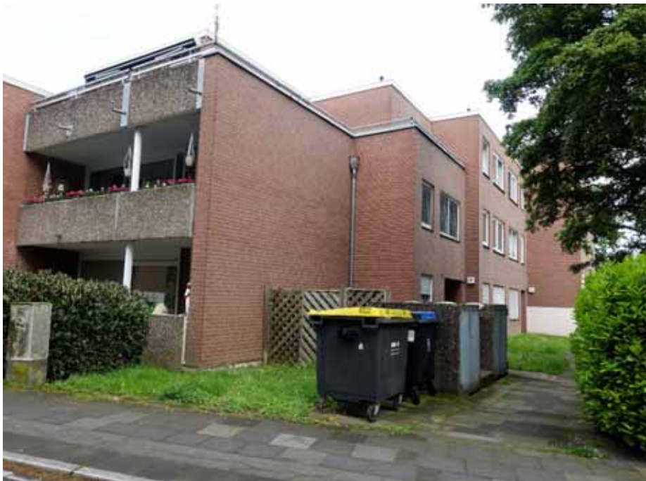
Zuwegung zu den Mehrfamilienhäusern „Hahnenstraße 12, 14“
