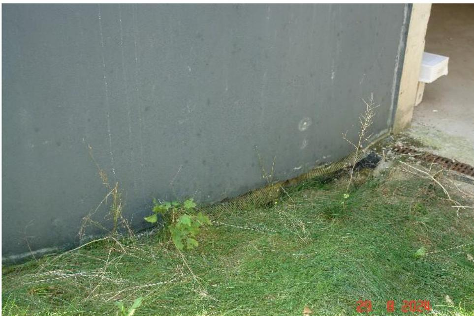
Bild 16: Feuchtigkeitsschäden und Restarbeiten Tiefgarage
