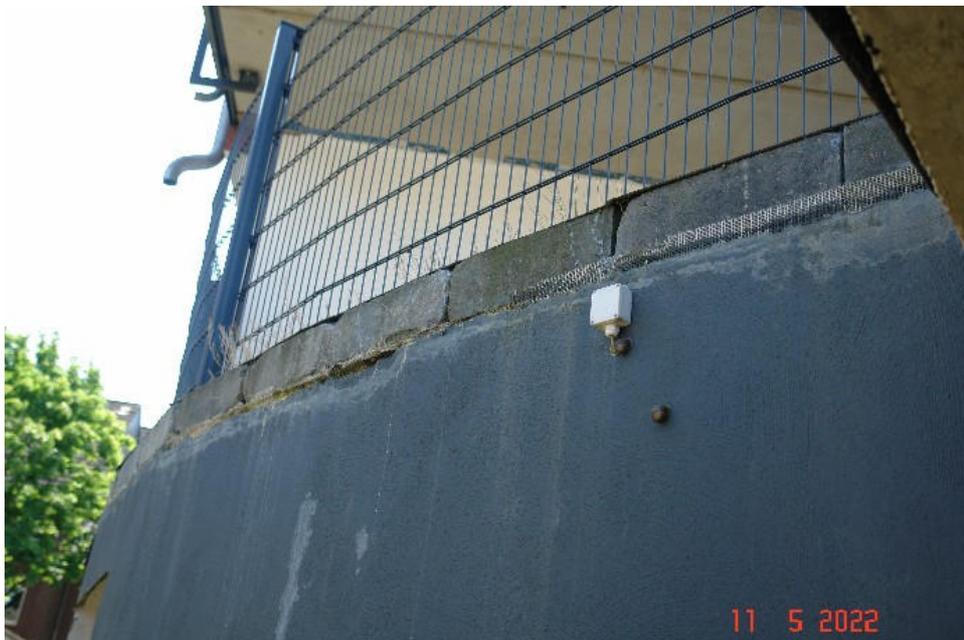
Bild 12: Leichte Feuchtigkeitsschäden im Bereich der TG-Zufahrt
