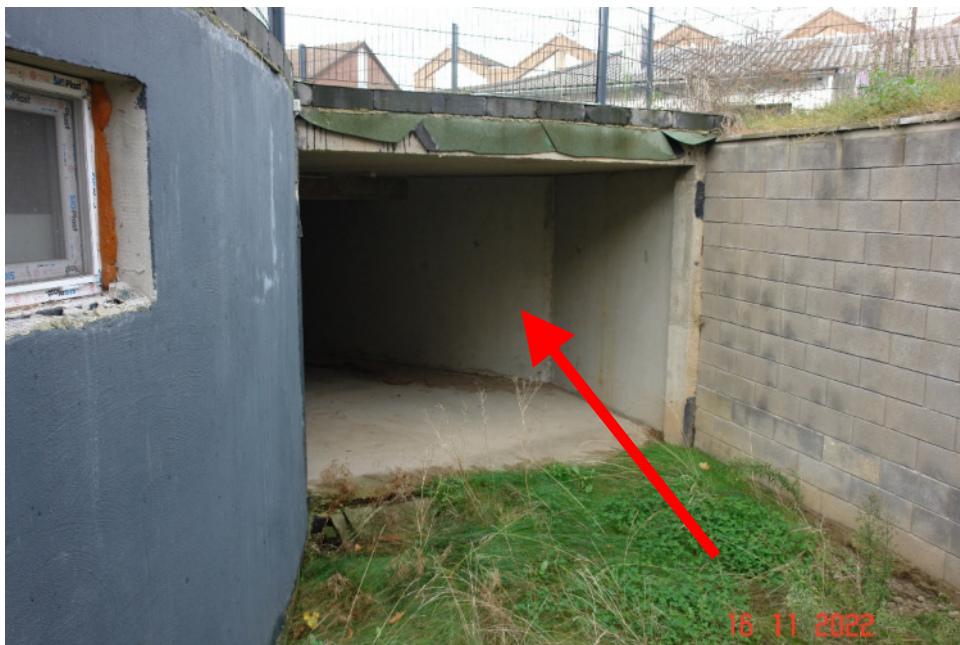
Bild 4: Noch einzubauendes Sektionaltor
