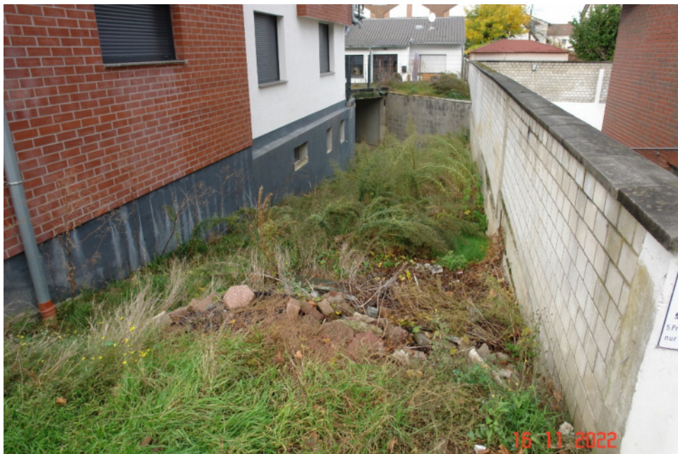
Bild 9: Noch zu erstellende TG-Zufahrt
