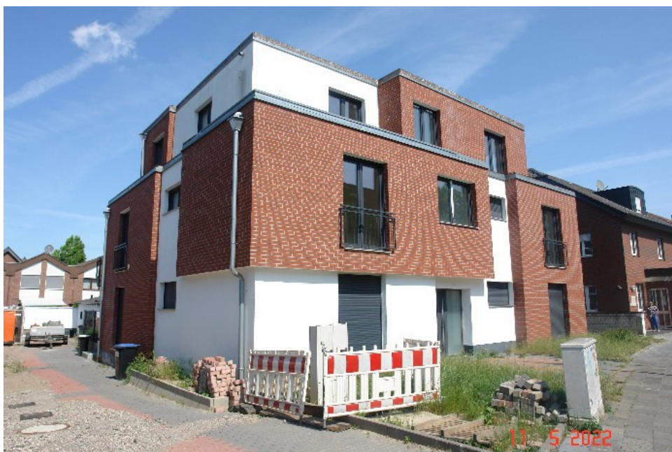
Bild 2: Ansicht des Bewertungsobjekts aus südlicher Richtung
