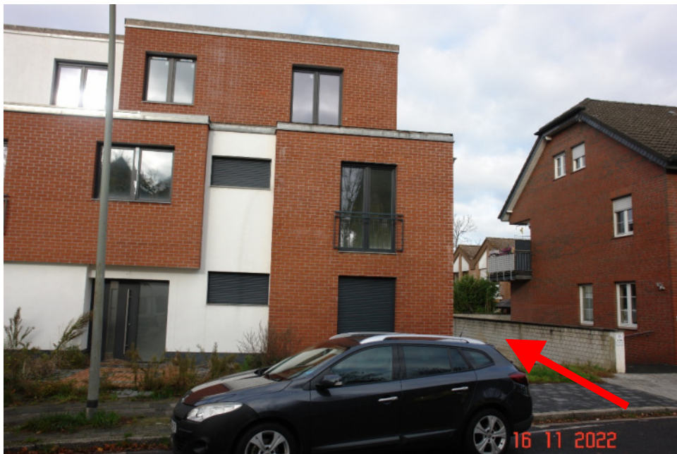
Bild 3: Ansicht der Bewertungsobjekts von der Straße aus
