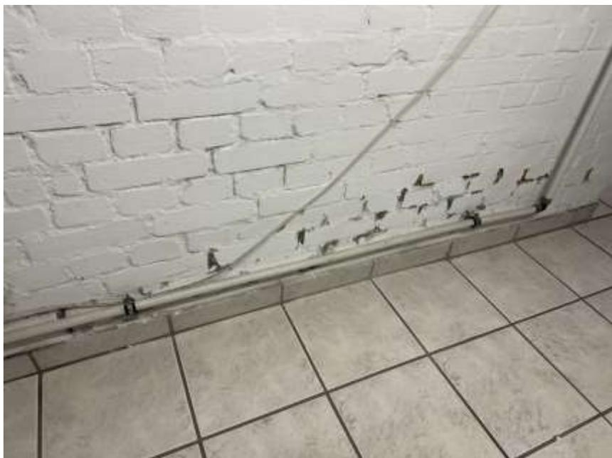
Bild 30: Kellergeschoss Feuchtigkeitsmerkmale
