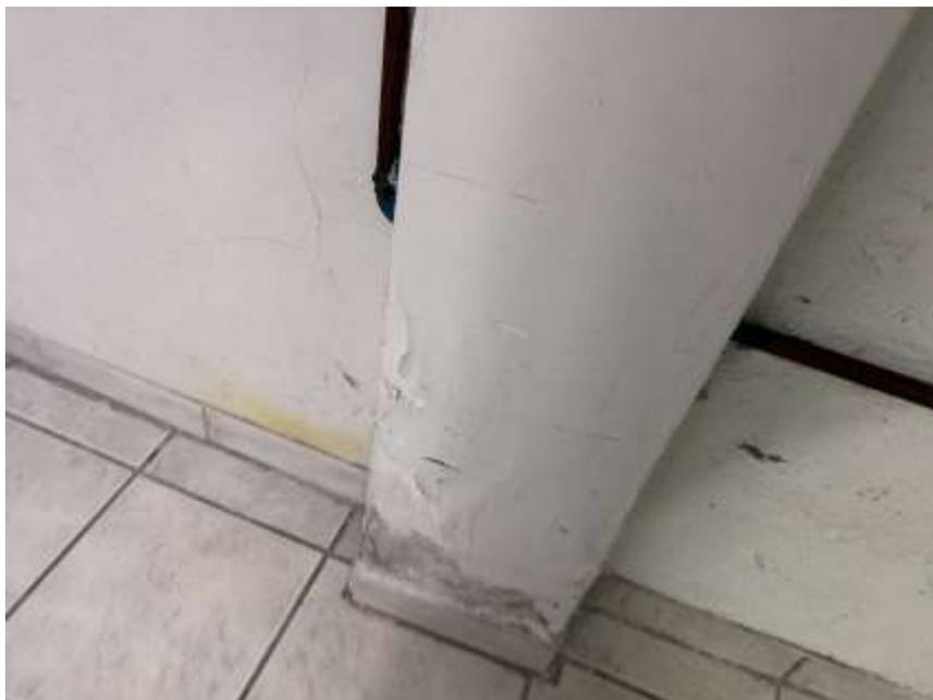
Bild 31: Kellergeschoss Feuchtigkeitsmerkmale
