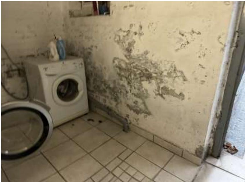
Bild 24: Kellergeschoss mit Mauerwerksdurchfeuchtungen
