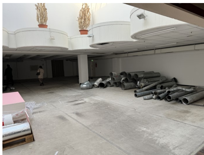
Foto Nr. 3 Fläche Shop 22 1. OG
