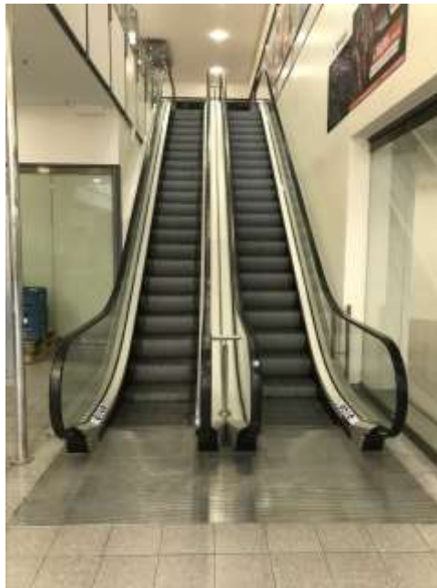
Bild 13: Rolltreppen zu den Obergeschossen
