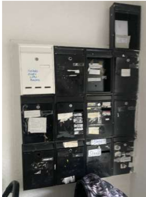
Bild 9: beschädigte Briefkastenanlage
