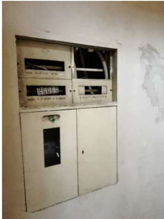
Bild 31: Innenansicht Unterverteilung
