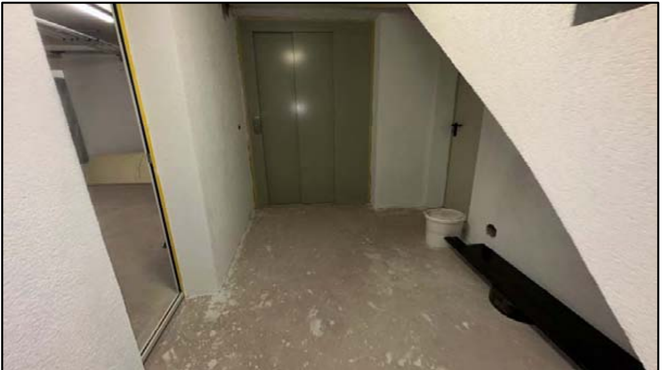
Treppenhaus im Kellergeschoss
