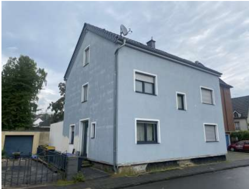
Bild 1: Ansicht des Bewertungsobjekts aus südwestlicher Richtung
