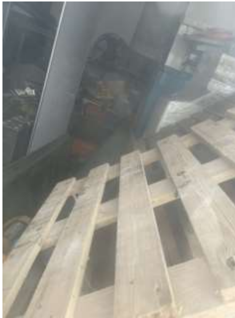
Bild 11: Innenansicht Gewerbe EG (Einsicht durch Fenster)
