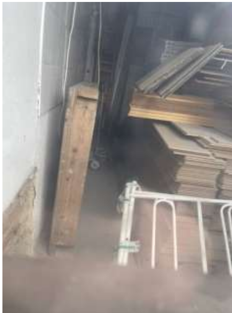
Bild 12: Innenansicht Gewerbe EG (Einsicht durch Fenster)
