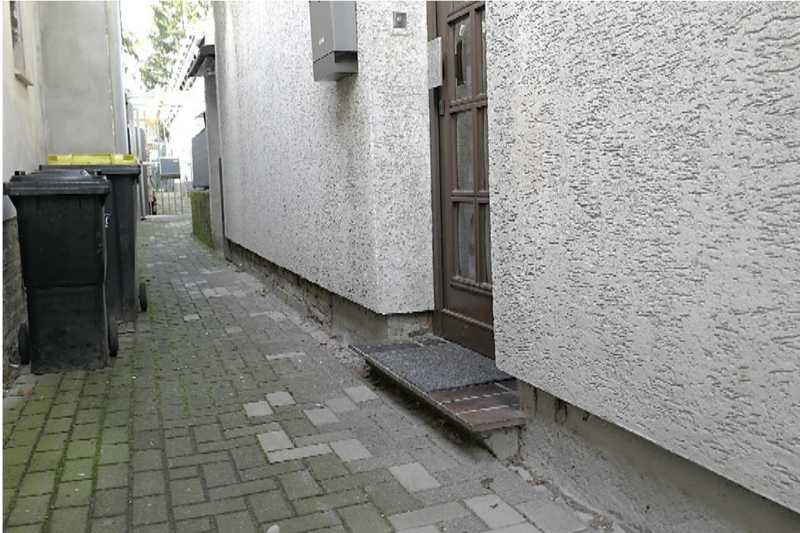
Eingang zum Wohnhaus Katzengasse 19
