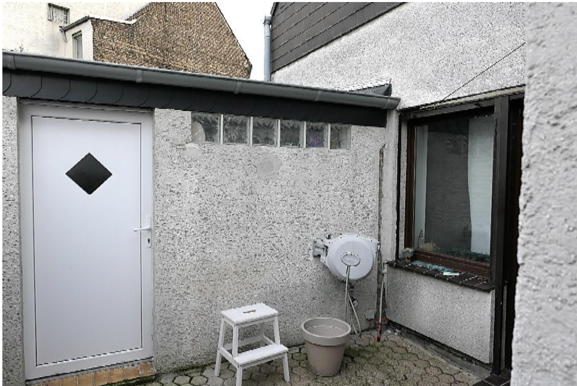
Rückseitiges Grundstück mit Nebengebäude
