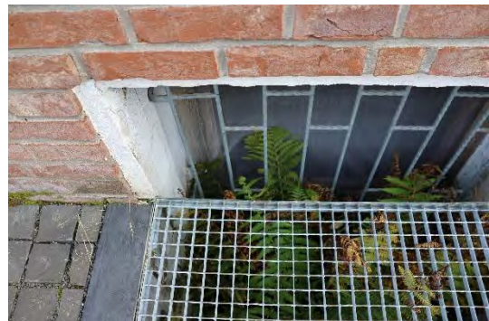
Lichtschächte mit Rostabdeckung
