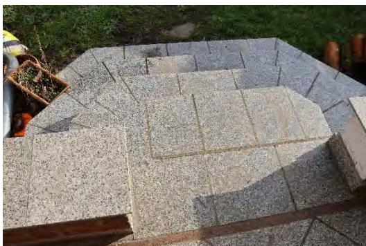
Abgang Terrasse in den Garten
