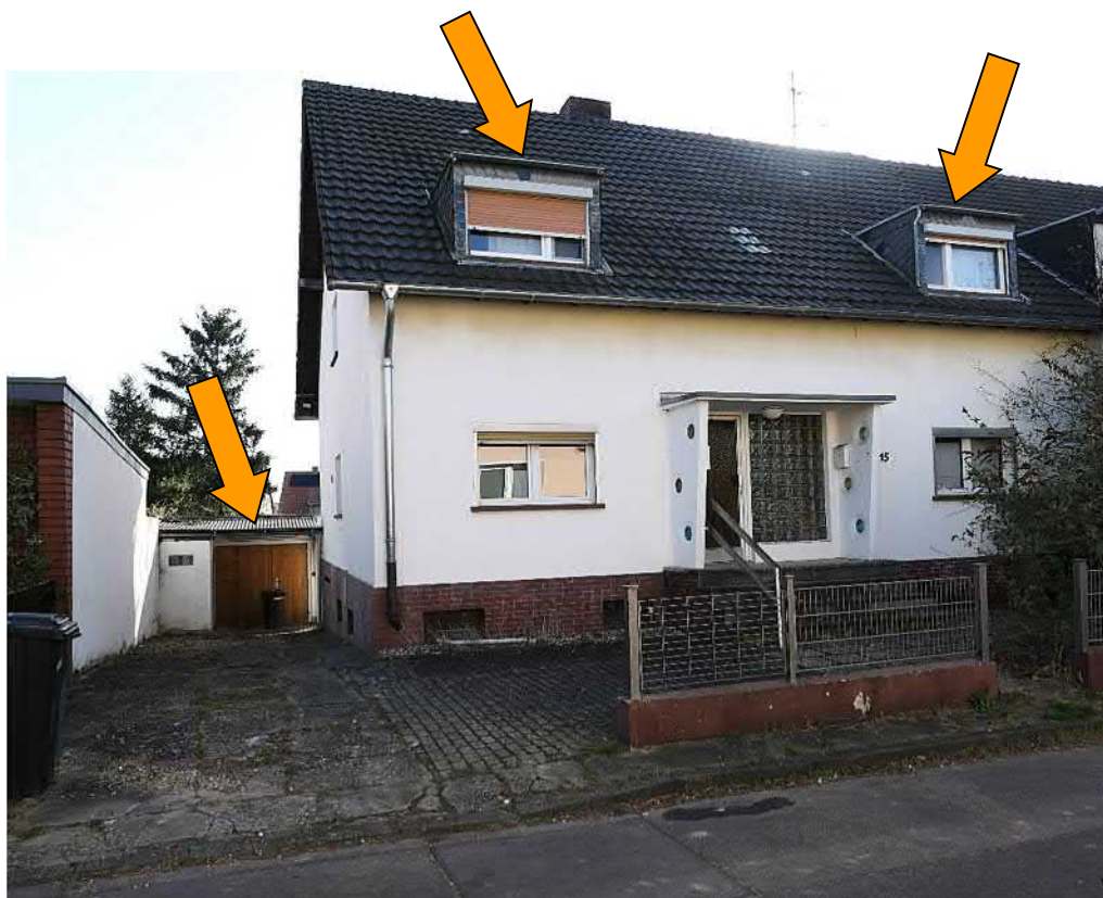
Straßenansicht von Nordwesten
