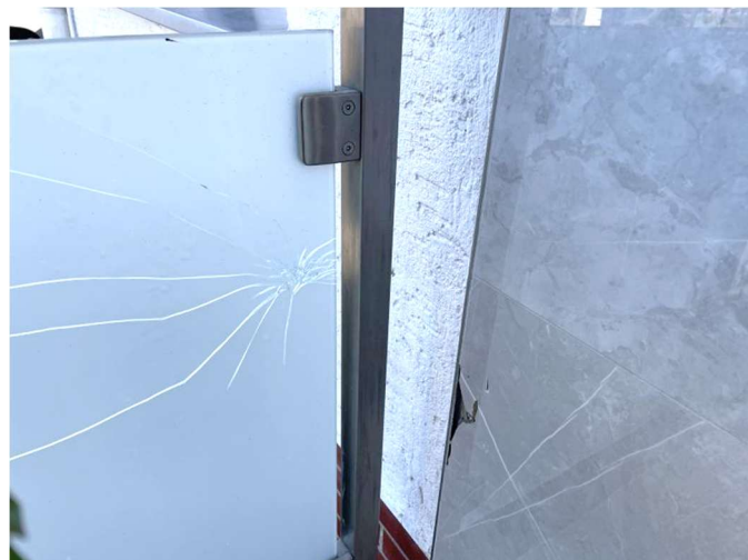
Schaden am Geländer der Hauseingangstreppe
