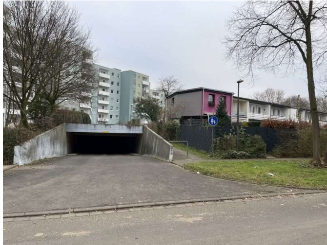
Ein-/Ausfahrt Tiefgarage an der Amsterdamer Straße
