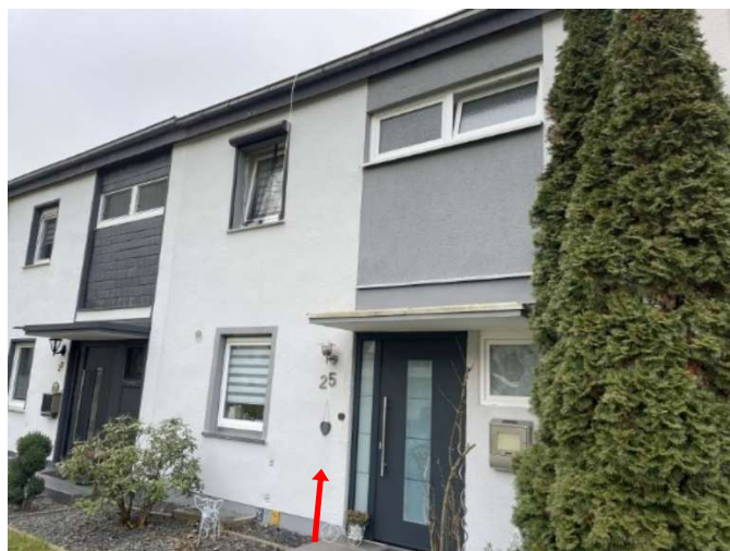
Amsterdamer Straße 25 - Nordostansicht
