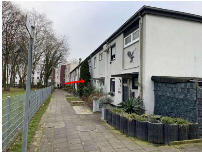
Amsterdamer Straße 21 - 41 - Ansicht von Norden
