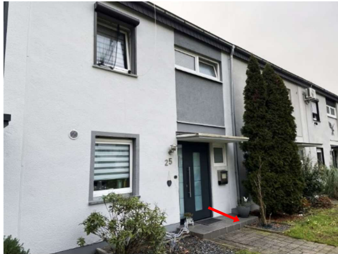
Amsterdamer Straße 25 - Südostansicht
