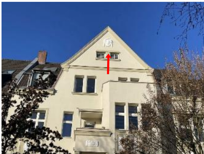
Raumeinheit Nr. 8 im Speichergeschoss
