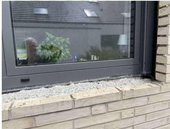
Fertigstellungsbedarf Fensterlaibungen
