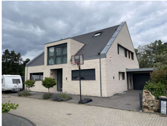
Einfamilienhaus mit Einliegerwohnung Feldhamsterstraße 33
