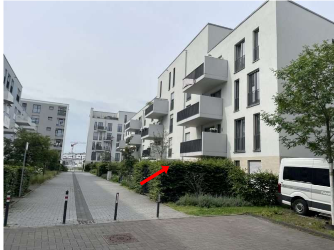
Mehrfamilienreihenhäuser Bertha-Sander-Straße 37 und 39
