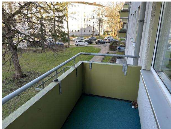
Balkon der Wohnung Nr. 147 im 1. Obergeschoss links
