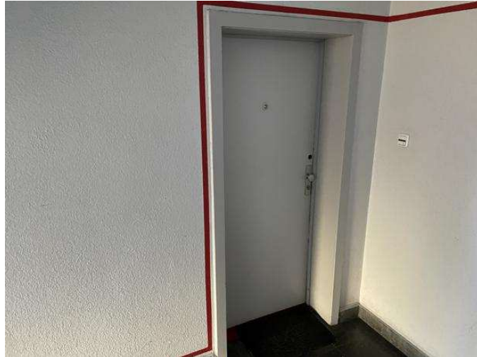
Eingangstür Wohnung Nr. 147 im 1. Obergeschoss links
