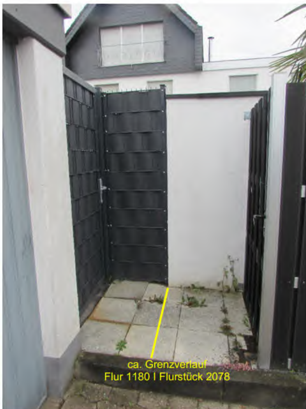
Foto 4: Zugangsfläche (Geh-/Fahrrecht, Abt. II, lfd. Nr. 3) zu den südwestlich angrenzenden, begünstigten Grundstücken 1180, 1178 und 1176
