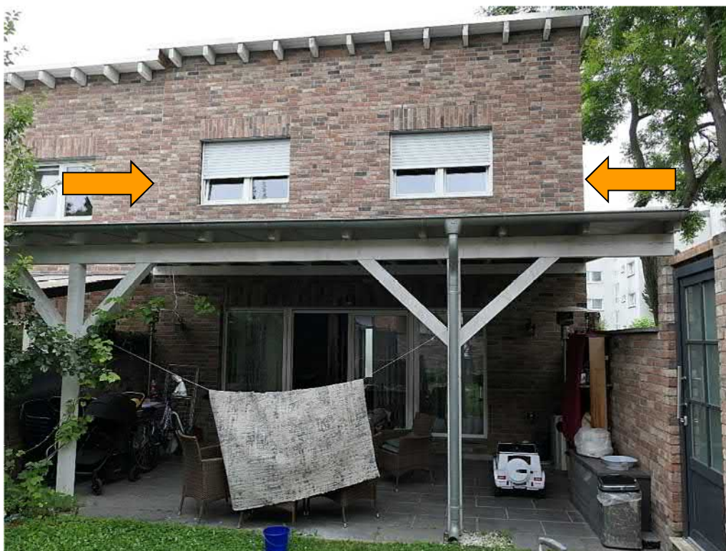
Rückseitige Ansicht mit überdachter Terrasse
