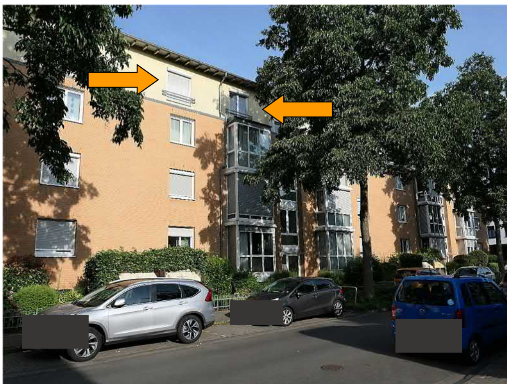
Straßenansicht von Südosten
