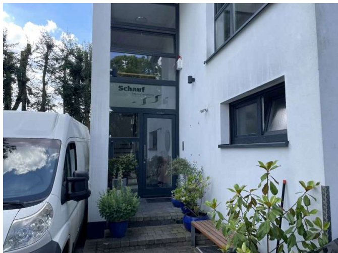
Hauseingang zum Keller- und Obergeschoss
