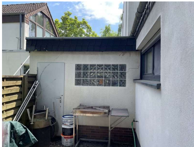
Pkw-Garage - hintere Ansicht
