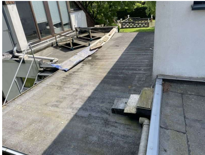
Garagendach mit „Regenwasserabfluss“
