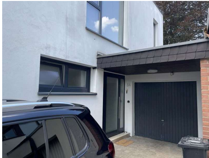
Hauseingang zum Erdgeschoss - Pkw-Garage
