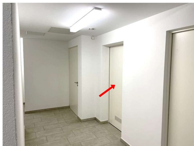
Kellerraum WE 2 zur Wohnung Nr. 2 im Erdgeschoss
