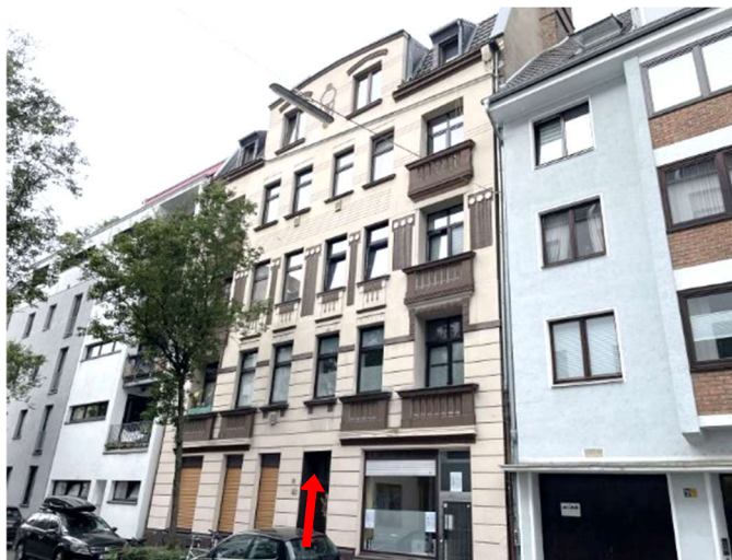
Wohn- und Geschäftshaus Zwirnerstraße 31
