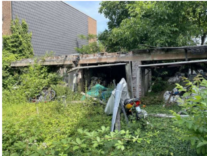
Pkw-Reihengaragen im hinteren Grundstücksbereich
