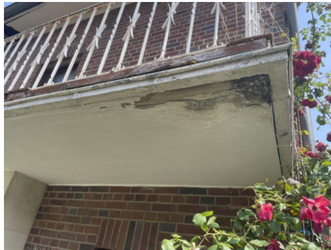
Balkon über der Hauseingangstür
