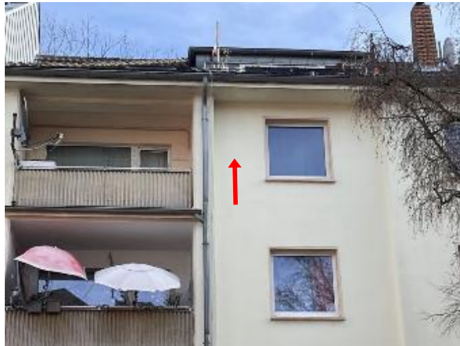
Wohnung Nr. 12 im 3. Obergeschoss rechts
