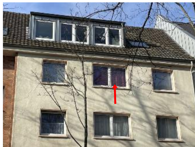
Wohnung Nr. 12 im 3. Obergeschoss rechts
