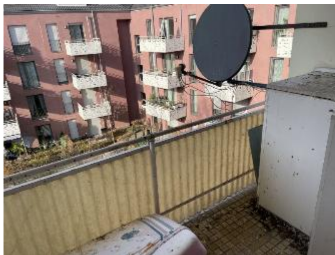
Balkon der Wohnung Nr. 12 im 3. Obergeschoss rechts
