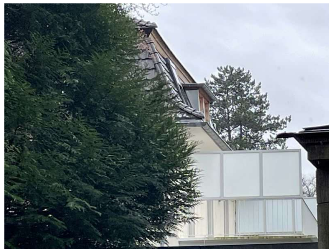
Balkon im Obergeschoss
