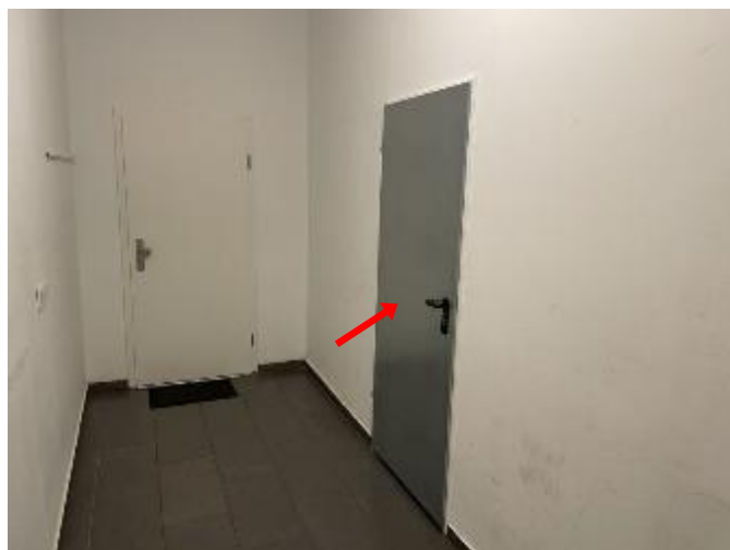
Tür zum Lagerraum Nr. 18
