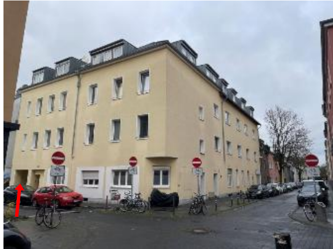
Mehrfamilienhaus Odenwaldstraße 49 / Nassaustraße 66, 68
