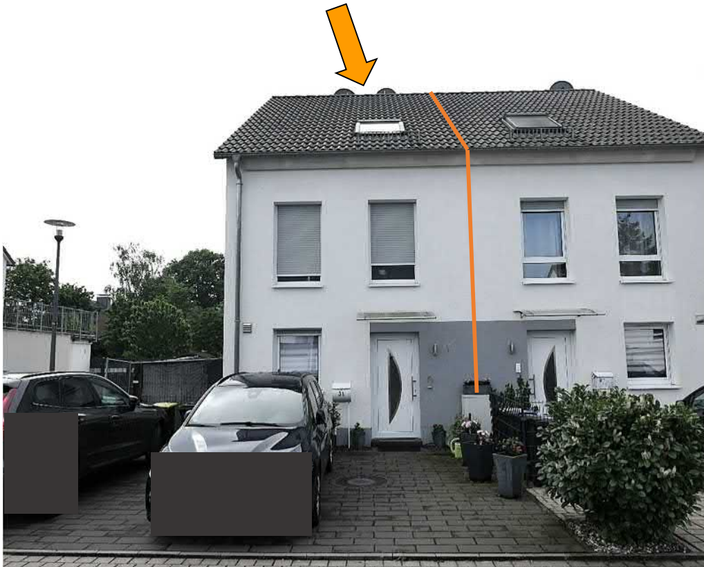
Straßenansicht von Nordwesten
