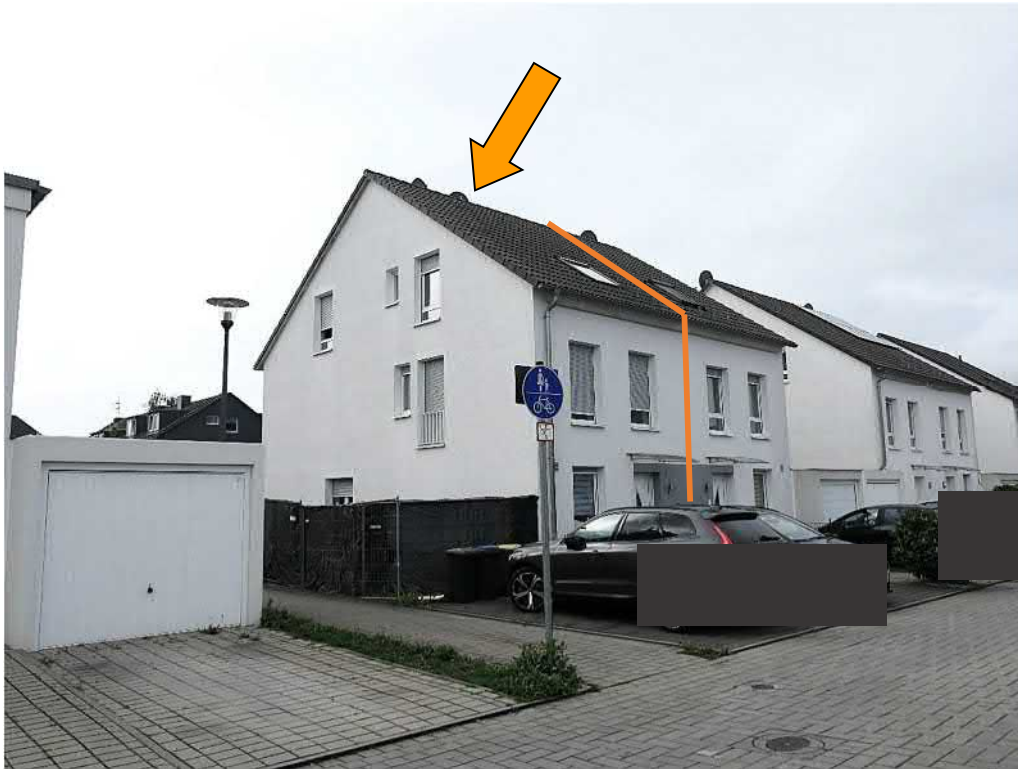
Straßenansicht von Nordosten
