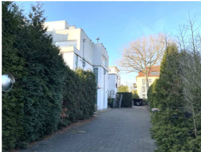
Zufahrt auf dem Grundstück an der Nordseite
