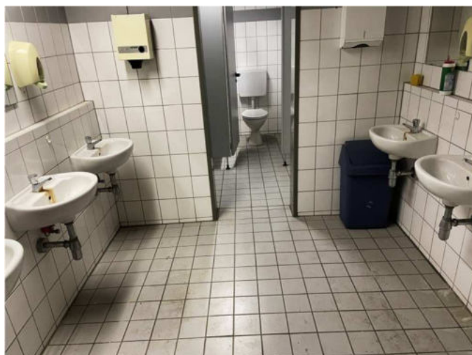
Sanitärraum im KG
