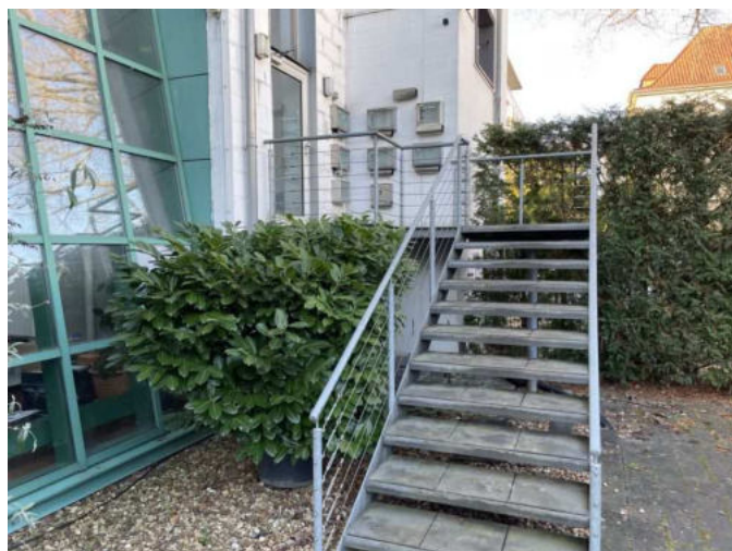
Treppe zum Hauseingang auf der Nordseite
