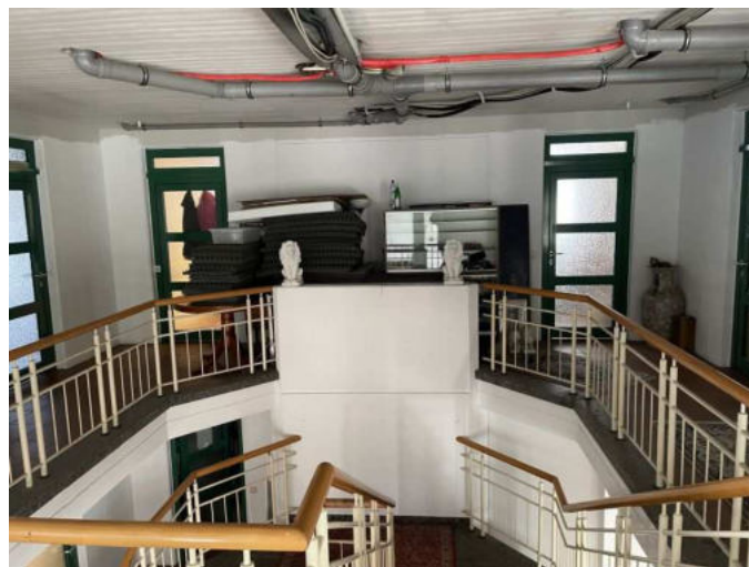
Treppenhaus vor den Büroeinheiten im 1. OG
