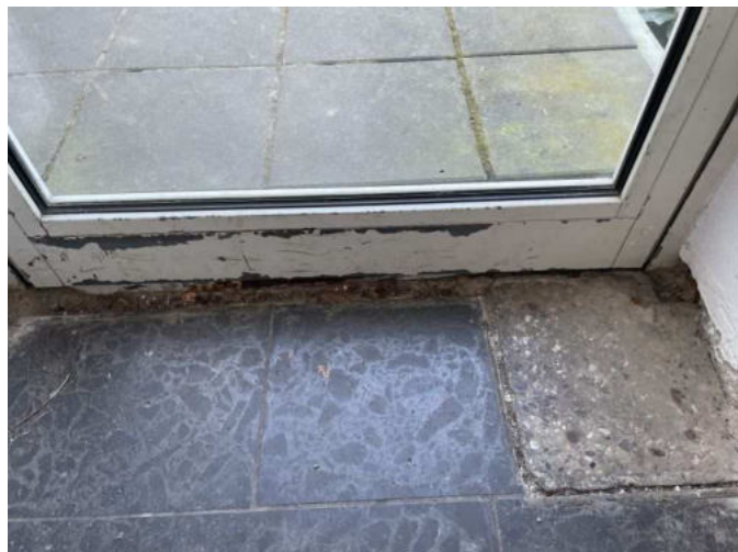
Instandsetzungsbedarf im Treppenhaus
