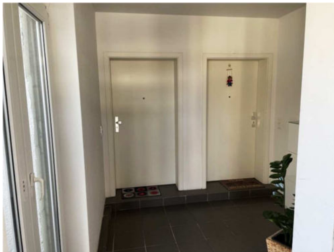
Wohnungseingangstüren im Staffelgeschoss
