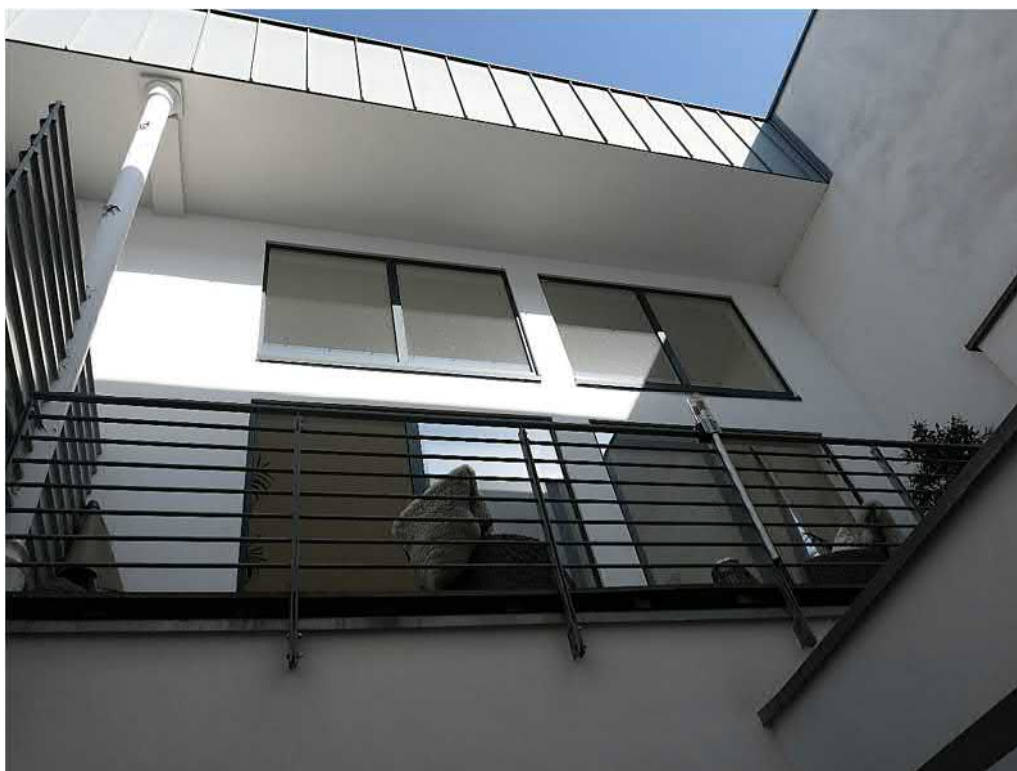
Rückseitige Ansicht (Obergeschoss mit Balkon)
