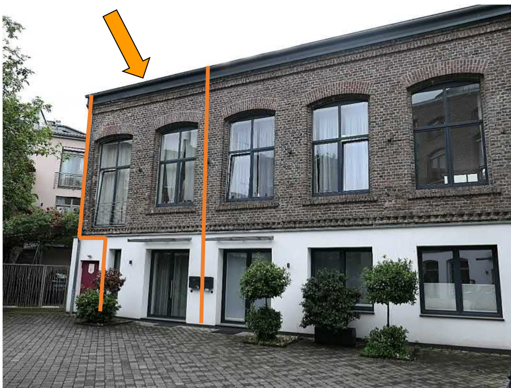
Ansicht Haus Nr. 41d von Westen
