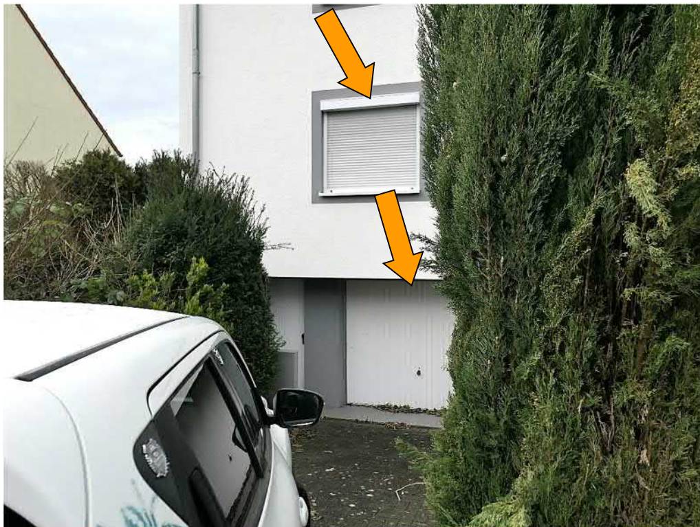
Ansicht von Nordosten mit Garage im Kellergeschoss
