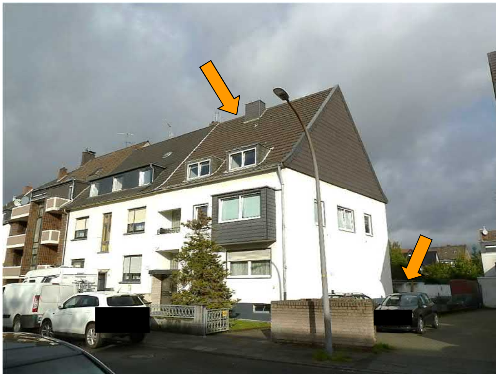
Straßenansicht von Südosten
