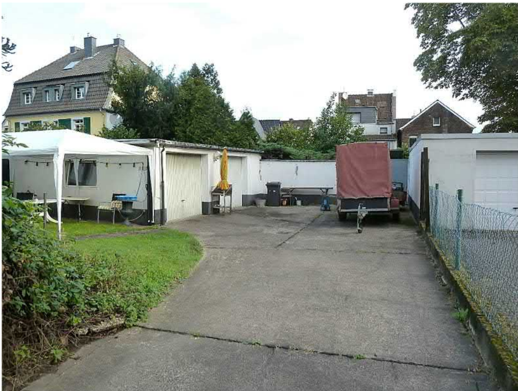
Ansicht Garagen mit Tor zum Nachbargrundstück (Wegerecht)
