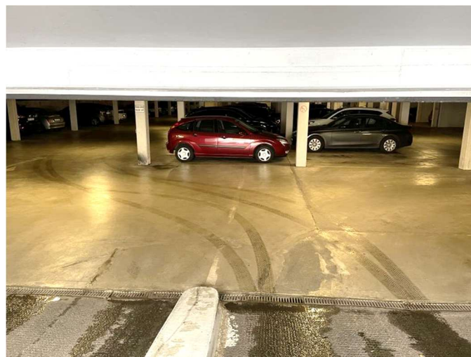
Einfahrt in die Tiefgarage
