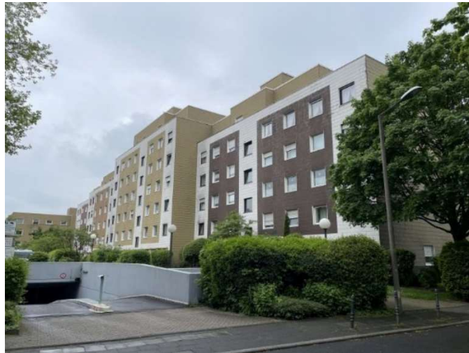
Tiefgaragenein-/ausfahrt Leipziger Straße 8 - 16
