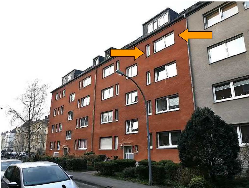
Straßenansicht von Nordosten
