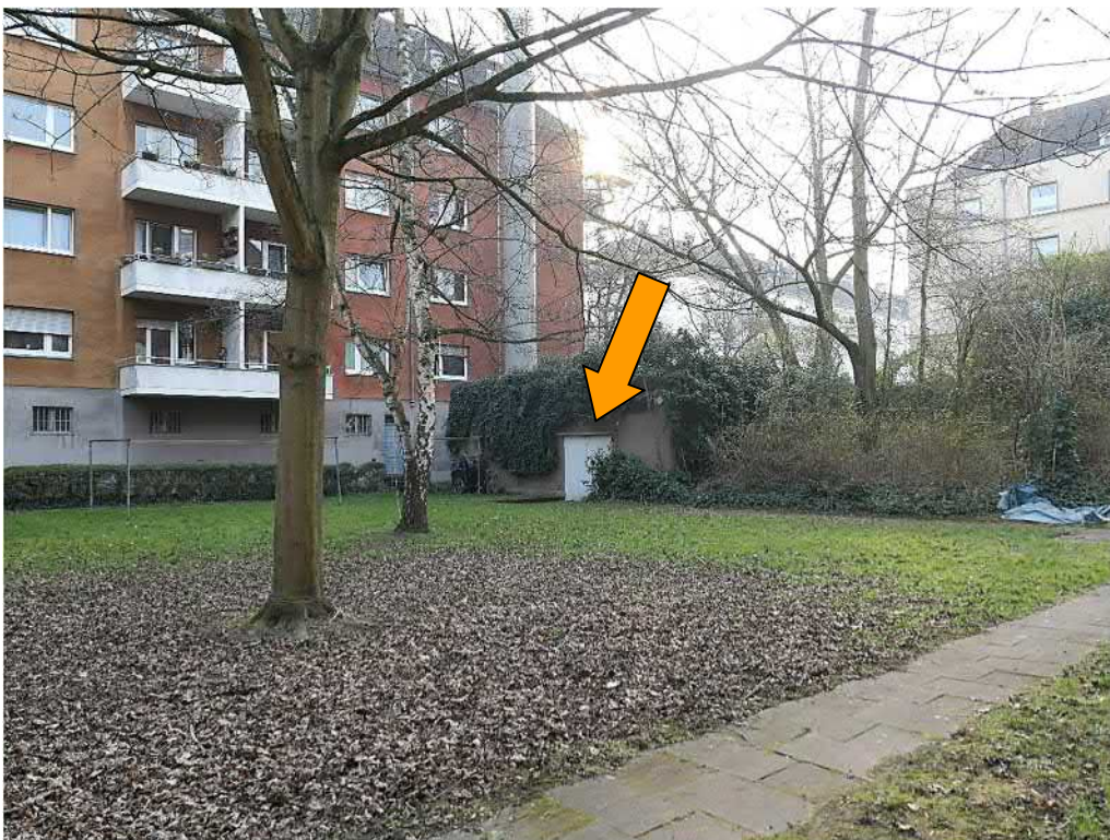
Gartenbereich mit Heizzentrale
