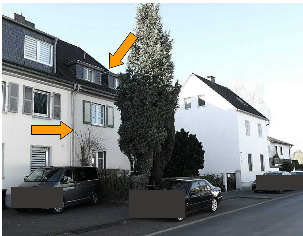
Straßenansicht von Nordosten
