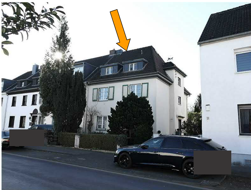
Straßenansicht von Nordwesten
