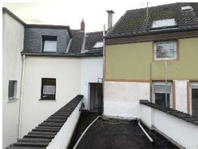
Balkon zum Appartement im Obergeschoss
