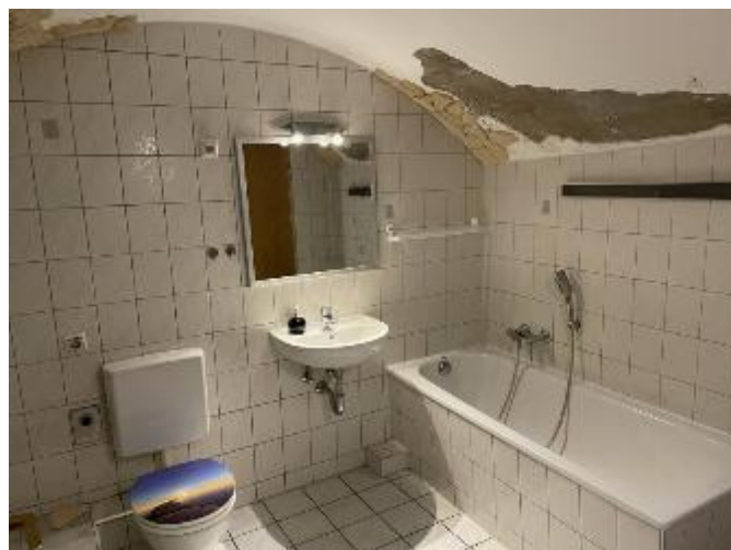
Bad im Kellergeschoss zur Wohnung im Erdgeschoss
