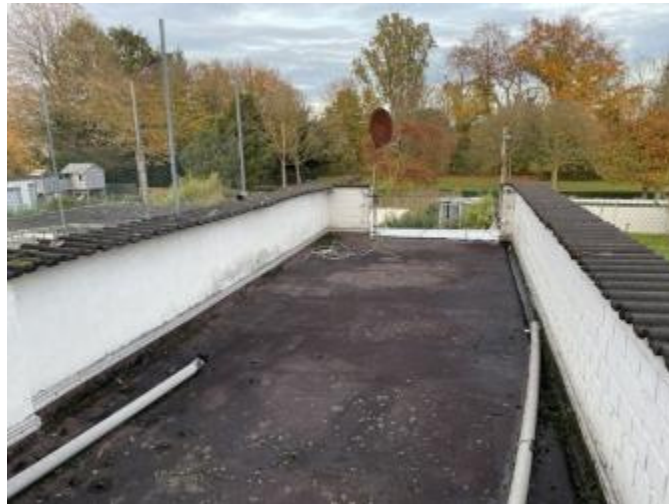
Balkon zum Appartement im Obergeschoss
