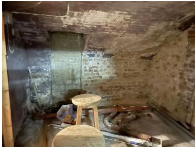
Raum im Kellergeschoss
