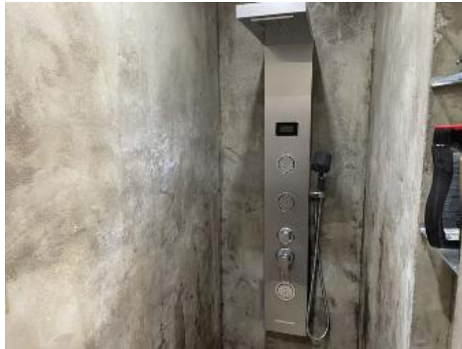
Bad im Obergeschoss
