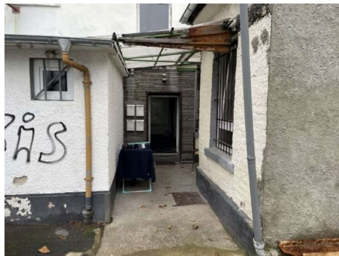
Hauseingang zwischen den Anbauten
