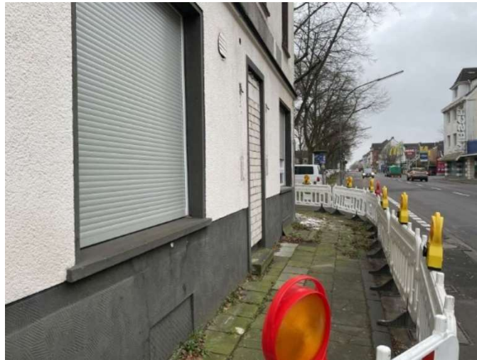
Abgesperrter Bereich vor dem Haus
