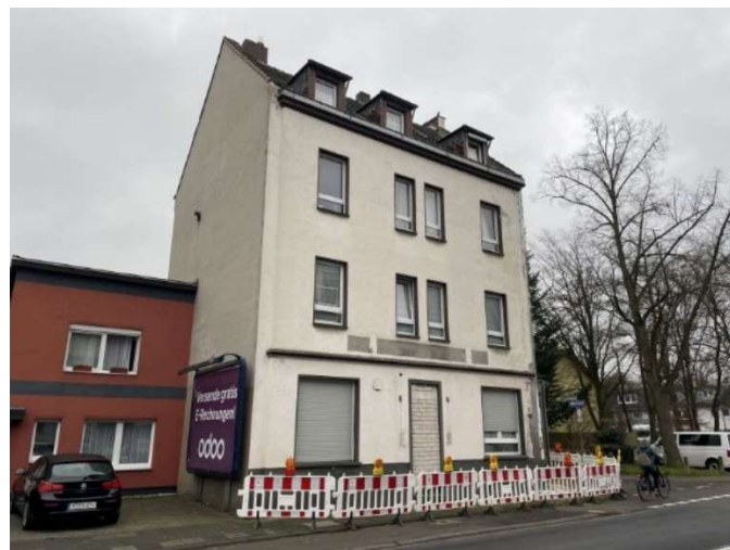
Ansicht von der Bergisch Gladbacher Straße
