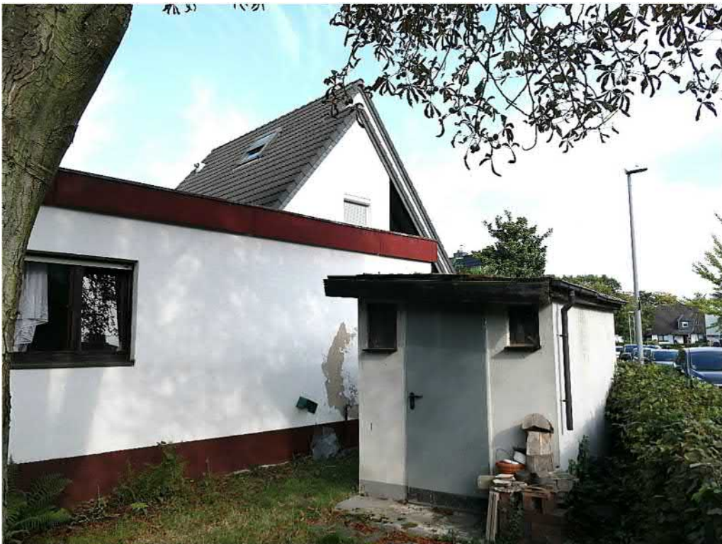
Straßenansicht von Südosten (Anbau, Abstellschuppen)
