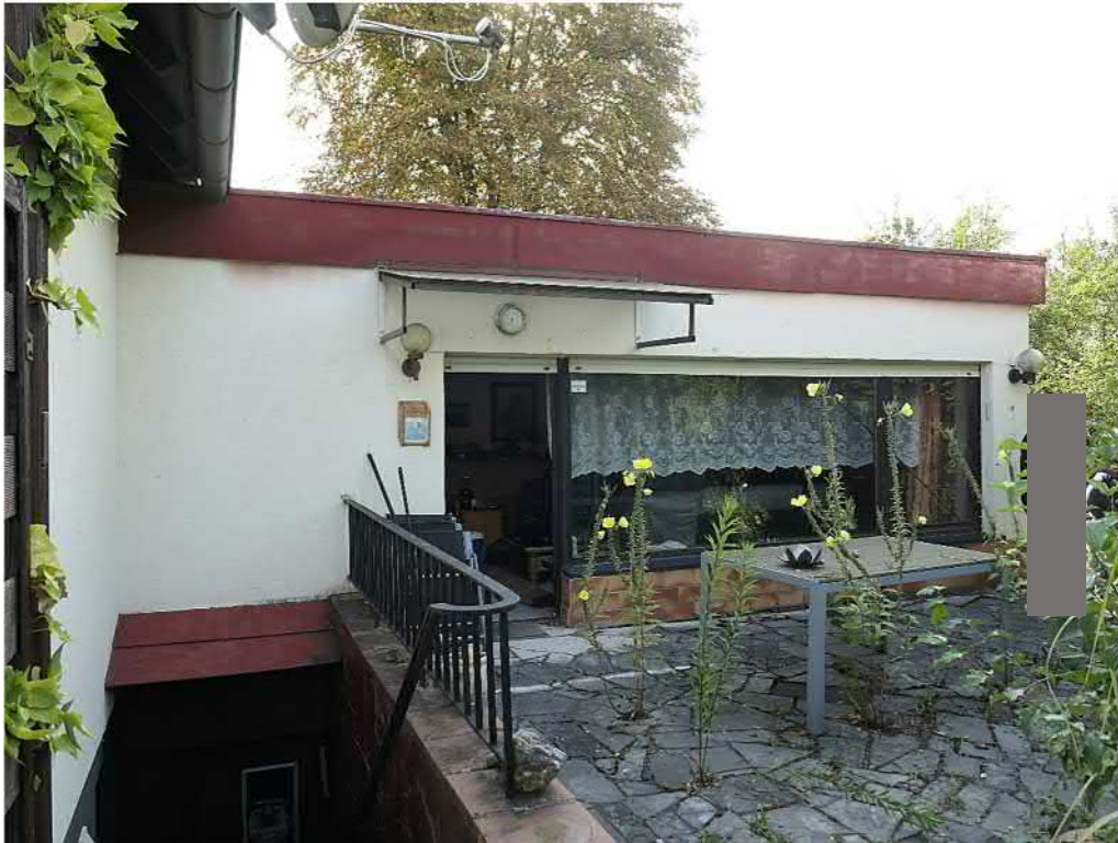
Rückseitige Ansicht Anbau
