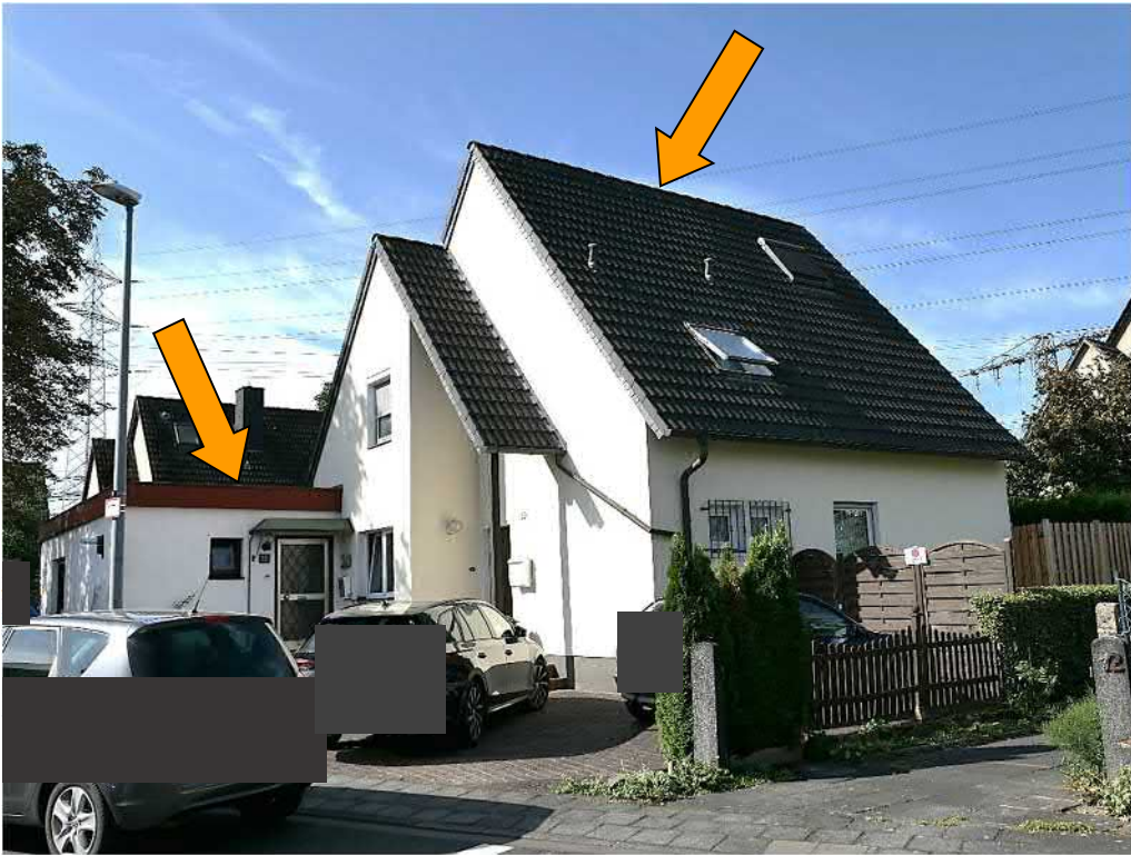
Straßenansicht von Nordosten
