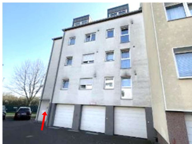
Mehrfamilienreihenendhaus Mülhauser Str. 4 a mit Hauseingang
