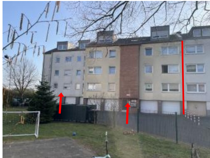
Mehrfamilienhäuser Mülhauser Straße 4 und 4 a
