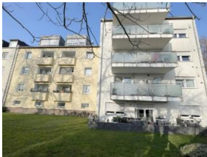
Rückwärtige Ansicht Mülhauser Straße 4 und 4 a
