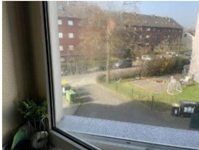
Schäden in einer Wohnung Mülhauser Straße 4
