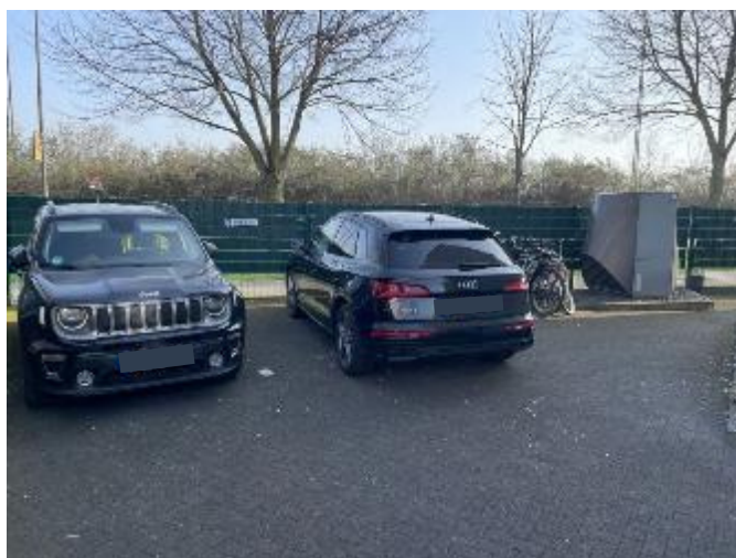
Pkw-Stellplätze und Wärmepumpe hinter dem Haus Nr. 4 a
