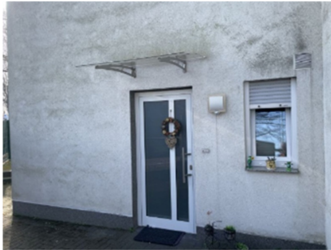
Mülhauser Str. 4 a / Wohnungseingangstür im Garagengeschoss
