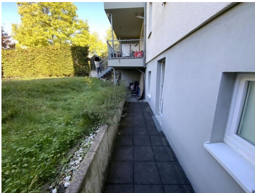
Bild 5: Lichthof vor den Kellerräumen
